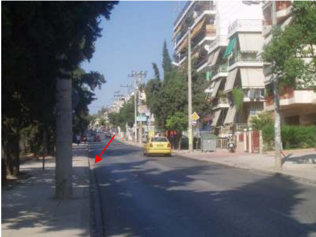
Εικ. 94 Χαρακτηριστική εικόνα από τη Λεωφόρο δημοκρατίας στο ύψος του πάρκου Α. Τρίτση. Φαίνεται το φτωχό σύστημα αποστράγγισης εκατέρωθεν του δρόμου.
