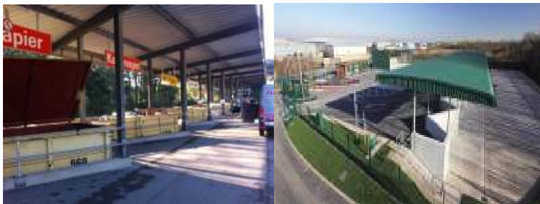
Εικόνα 12: Χώρος διαλογής μικρών ανακυκλώσιμων υλικών
