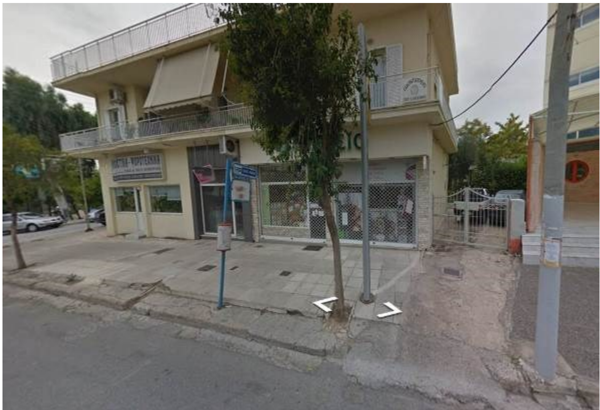
Εικόνα 47 - Στάση ΠΛ. ΡΙΜΙΝΙ (ΙΠΠΟΔΑΜΕΙΑΣ)
