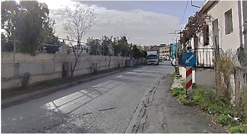
Φωτογραφία 1.5: Στένωση της οδού Φλέβας Ρουβίκωνος
